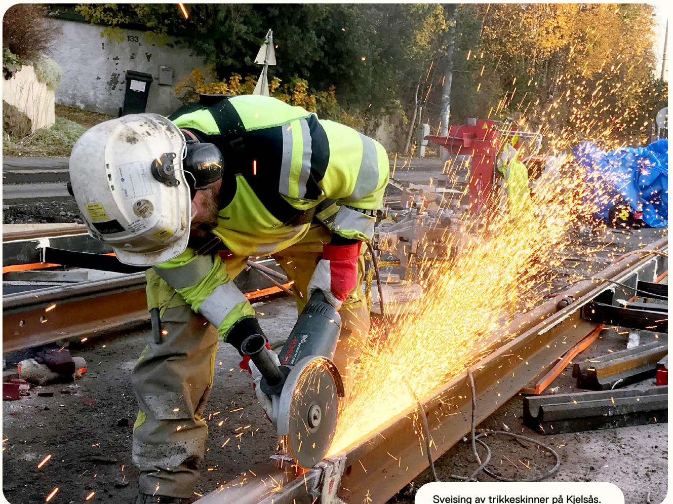
Oppgraderingsarbeid mellom Tøyen og Carl Berners plass.
